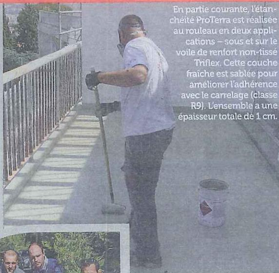
En partie courante, l'étanchéité ProTerra est réalisée au rouleau en deux applications – sous et sur le voile de renfort non-tissé Triflex. Cette couche fraîche est sablée pour améliorer l'adhérence avec le carrelage (classe R9). L'ensemble a une épaisseur totale de 1 cm.
