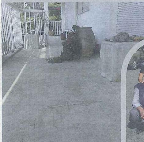
▲ Le système BWS Triflex permet de conserver le revêtement d'origine fortement fissuré par 45 ans d'intempéries. Il est poncé, soufflé et reprofilé afin de faciliter l'accrochage du primaire.
