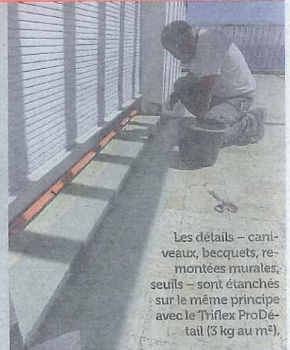
Les détails – caniveaux, beccquets, remontées murales, seuils – sont étanchés sur le même principe avec le Triflex ProDétail (3 kg au m<sup>2</sup>).
